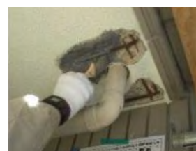
鉄筋露出補修(例)
